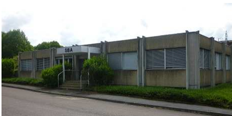
Entrée des bureaux
